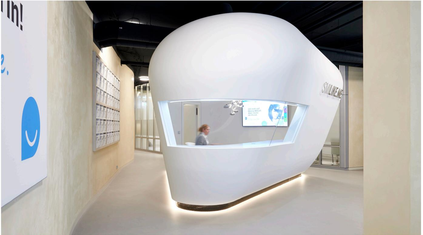
Gestaltung mit Knauf Systemlösungen: Was auch immer an ungewöhnlichen Formen und Flächen vorstellbar ist – mit Knauf sind sie eins zu eins realisierbar. Für die nötige Flexibilität sorgen Knauf Gips-Platten, als Formteile mit unterschiedlichen Biegeradien sowie Systemlösungen für Kuppeln – inklusive Verspachtelung in gewünschter Oberflächenqualität.
