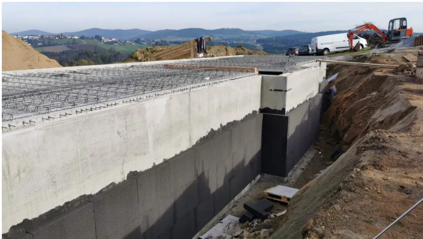
Kellerdämmung mit GLAPOR Schaumglasplatten
