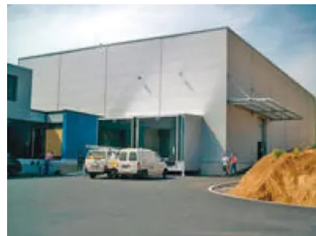
Warmluftheizungen mit Flüssiggas
