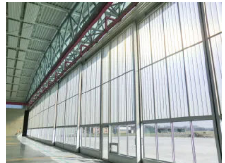
Hangarschiebetor mit Verglasung
