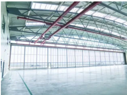
Hangartor mit Tageslichtelementen
