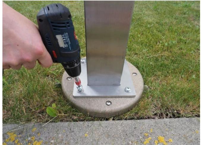
Die Trägerplatte aus Polymerbeton ist witterungsbeständig, lässt sich bearbeiten wie Beton und hält bis zu 100 kg Zugkraft stand. Endgeräte wie Steckdosenleiste, Wegeleuchte, Sicherheitskamera oder E-Ladestele können einfach angeschraubt werden. Die ETGAR Fundament-Box kann im Rasen, im Blumenbeet aber auch in der gepflasterten Einfahrt verbaut werden.
