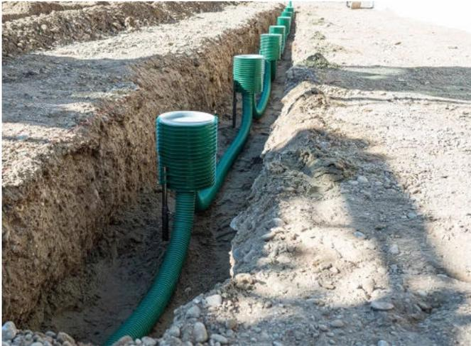
Die ETGAR Fundament-Box mit Trägerplatte bildet ein anschlussfertiges Fundamentsystem. Sie bietet die Möglichkeit zur Leerrohraufnahme, ausreichend Kapazität zur unterirdischen Verkabelung und gleichzeitig ausreichend Stabilität zur Aufnahme von elektrischen Endgeräten.
