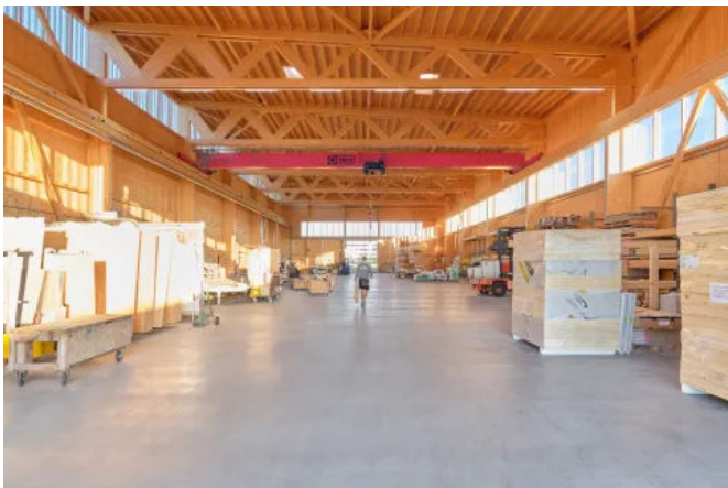
Hallenbau Produktionshalle (© Franziska Laub)
