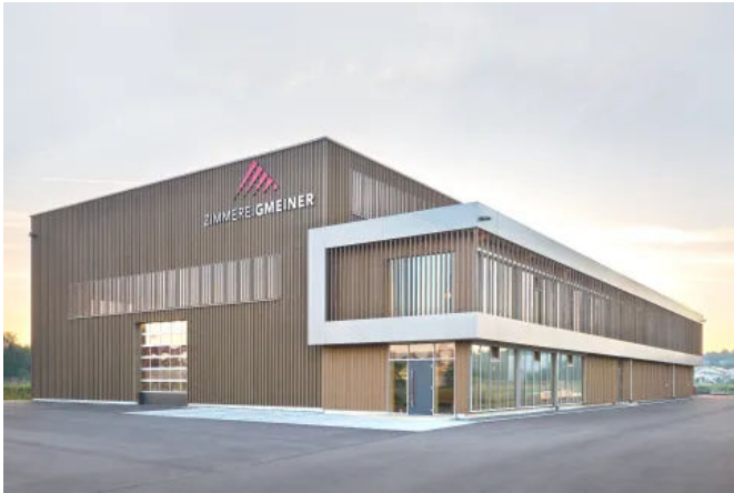
Hallenbau Zimmerei Gmeiner (© Franziska Laub)
