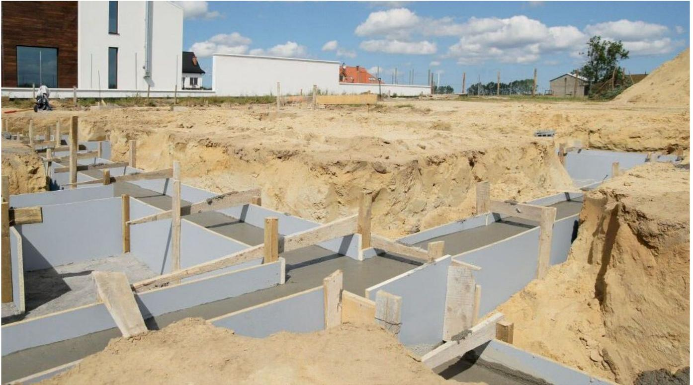
Die richtige Schalung im immer komplexer werdenden Betonschalungsbau ist für einen optimalen Einsatz des Betonteilbaus wichtig, um die gewünschte Formgebung, Oberflächenbeschaffenheit und Ebenheit zu erzielen. Pfeleiderer bietet für die Betonschalung qualitativ hochwertige, stabile und belastbare Holzwerkstoffe, die präzise und flexibel zu verarbeiten sind und gleichzeitig den Einsatzbedingungen am Bau gewachsen sind.
