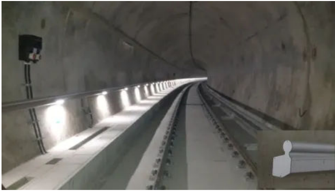
U-Bahn-Tunnel beim Bahnhof Großreuth, Nürnberg. Foto: LMT
