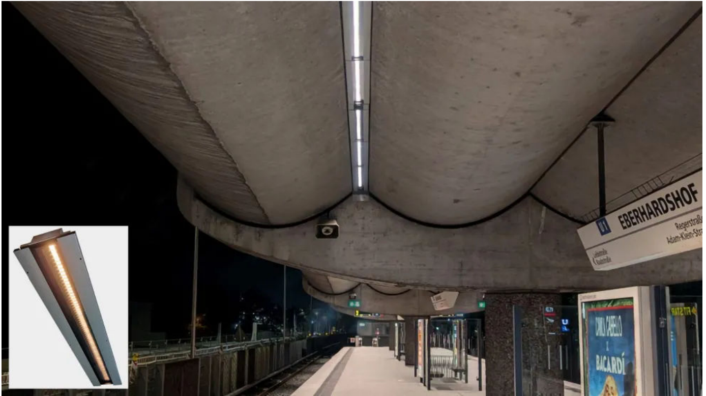
U-Bahnhof Eberhardshof, Nürnberg. Foto: LMT
