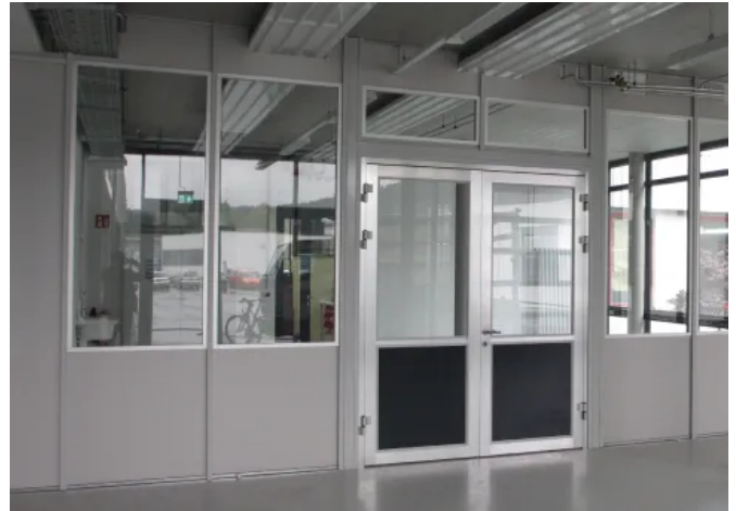
Trennwände im Eingangsbereich
