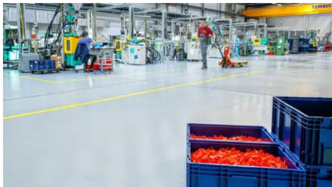
Verlaufbeschichtung ARTURO EP2500 in den Produktions- und Lagerhallen der Kissling Elektrotechnik GmbH
