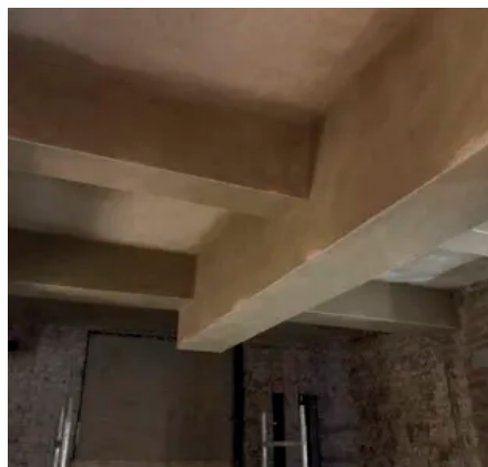
Kastenförmige Bekleidung von Deckenträgern
