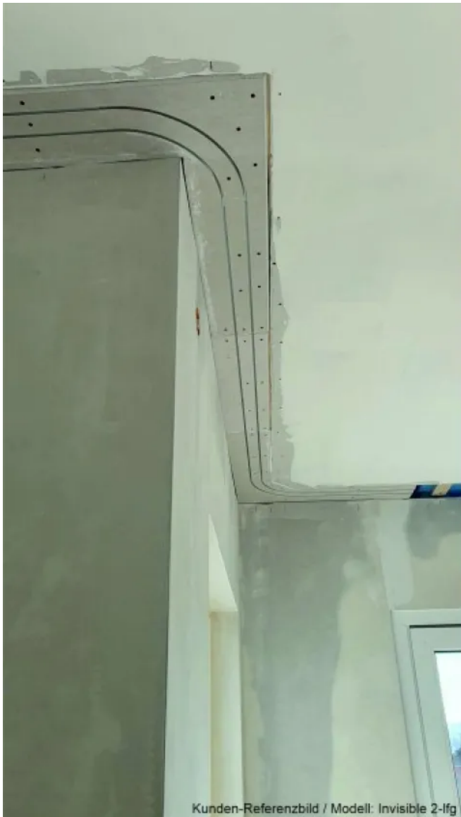
Trockenbaudecke mit integrierter Vorhangschiene Invisible im Rohbau
