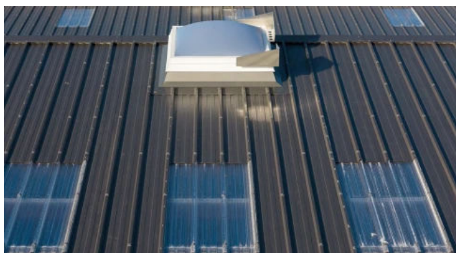
Dachsanierung einer Lagerhalle in Bocholt KS RW
