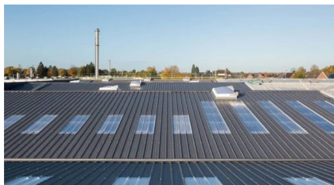
Dachsanierung einer Lagerhalle in Bocholt KS RW
