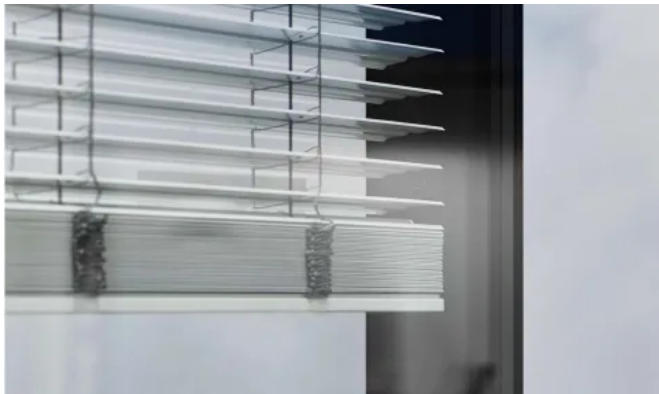
Raffstores mit Lichtenklammern sorgen für optimalen Lichteintrag. © BECKER LACOUR / Olaf Becker
