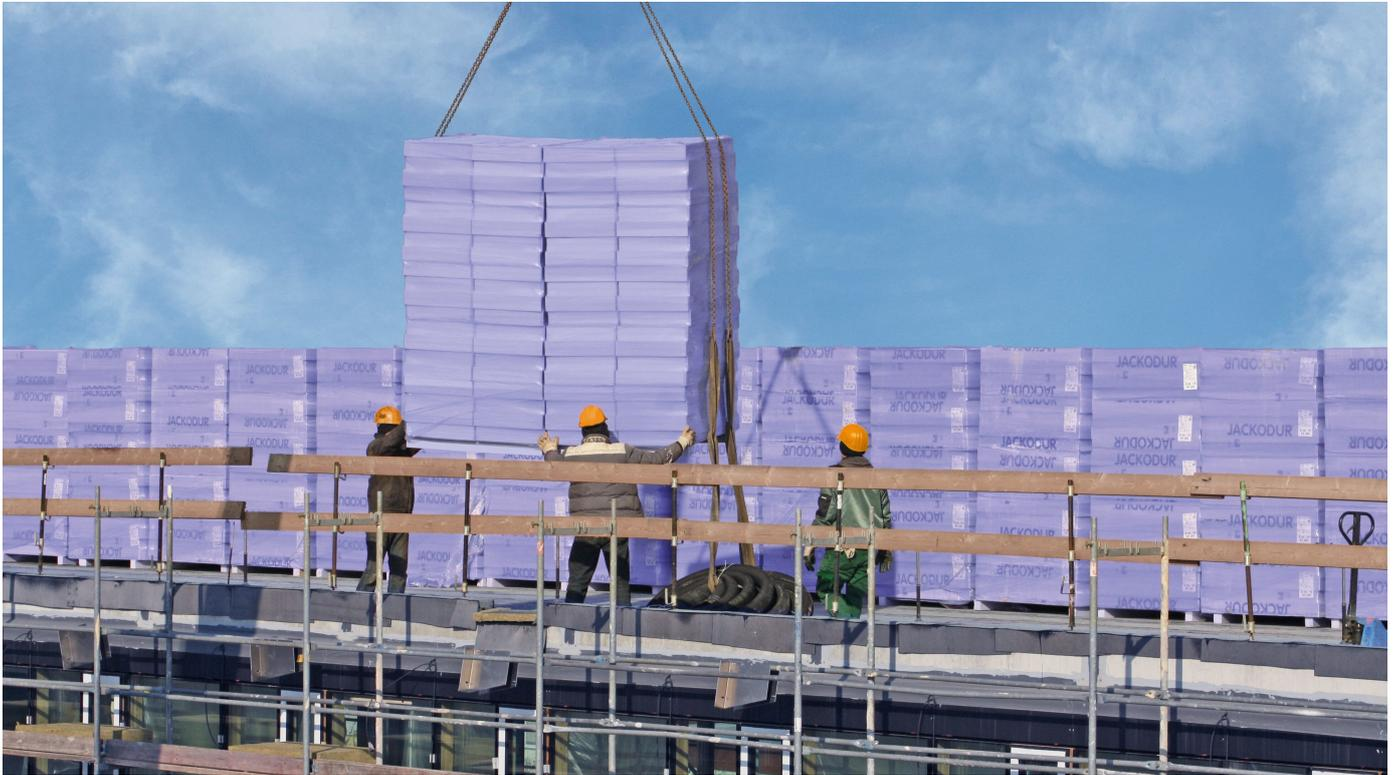
Die Vielfalt möglicher Nutzungen verdeutlicht die Grundanforderungen an die JACKODUR® Wärmedämmung: Sie muss extrem feuchtigkeitsunempfindlich, sehr maßstabstabil und äußerst druckfest sein. Mögliche Aufbauten sind das Retentionsdach, das Terrassendach, das begrünte, bekieste und befahrbare Dach.
