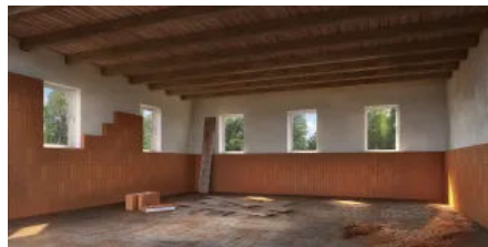
Während der Bauphase
