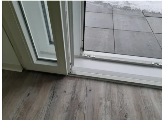
Barrierefrei: Kastenfenster als Balkontür mit 20 mm Flachschwelle
