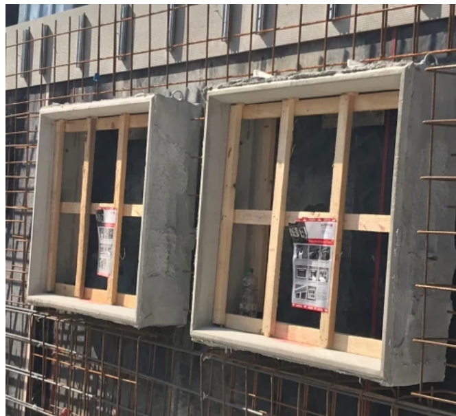
Kellerfenster-System Solitär Thermo-Baustelle
