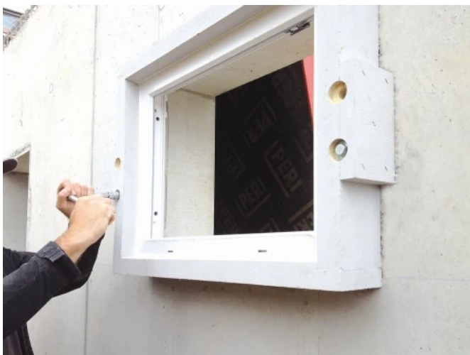
Kellerfenster-System CombiTherm - Baustelle
