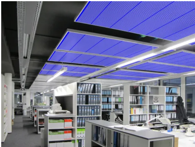
Darstellung der Metallsegel mit rückseitig fixierten Kapillarrohrrmatte vom Typ OVAMAT am Beispiel eines Bürogebäudes in München © Clina Heiz- und Kühlelemente GmbH
