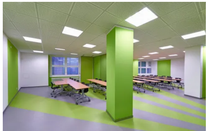
Fertiggestellte Rasterdecke mit Gipskartonkassetten als Heiz- und Kühldecke in einem Schulungsraum der SHK Innung Berlin ©Clina Heiz- und Kühlelemente GmbH
