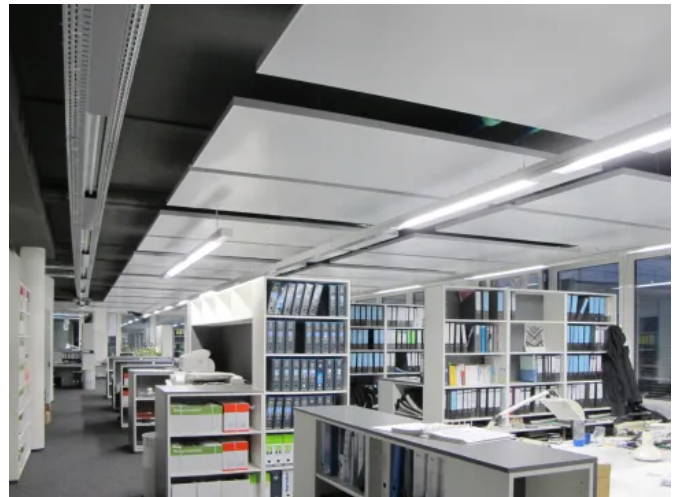
Fertiggestellte Decke mit Metallsegeln als Heiz- und Kühldecke in einem Bürogebäude in München © Clina Heiz- und Kühlelemente GmbH
