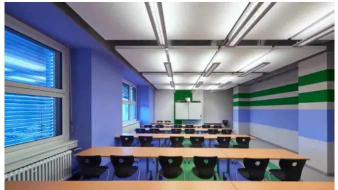
Fertiggestellte Decke mit Gipskartonsegeln ausgeführt mit OPTIPANEL 18 als Heiz- und Kühldecke in der SHK Innung Berlin © Clina Heiz- und Kühlelemente GmbH
