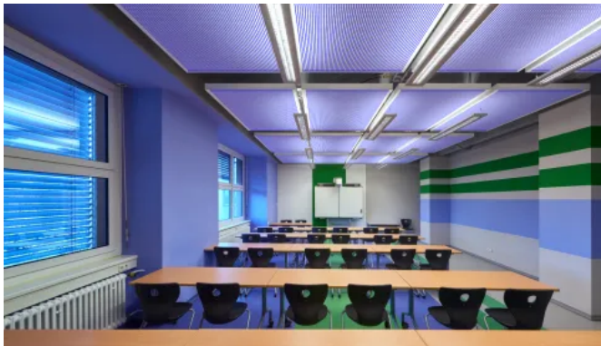
Darstellung der Gipskartonsegel ausgeführt mit OPTIPANEL 18, vorgefertigte Gipskartonplatten mit integrierter Kapillarrohrmatte, am Beispiel der SHK Innung Berlin © Clina Heiz- und Kühlelemente GmbH
