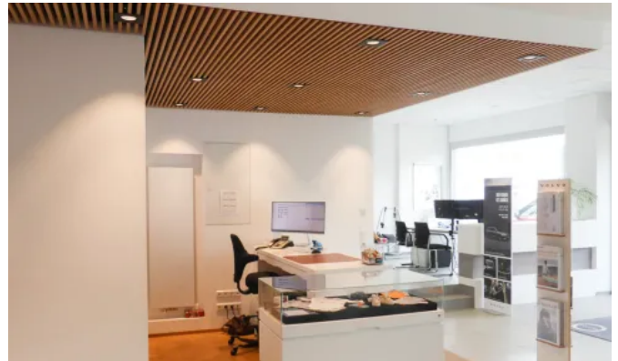
metogla Lamellendecken aus MDF-beschichteten Lamellen im Autohaus Leibssle GmbH, Reutlingen | Fotograf: Autohaus
