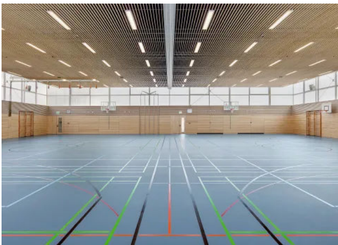
metogla Lamellendecken mit Lamellen aus Birke in der Sporthalle der Staatlichen Realschule für Mädchen, Neumarkt | Architekt: sturm+schmidarchitekten partnerschaft mbB, Pyrbaum | Fotograf: Erich Spahn
