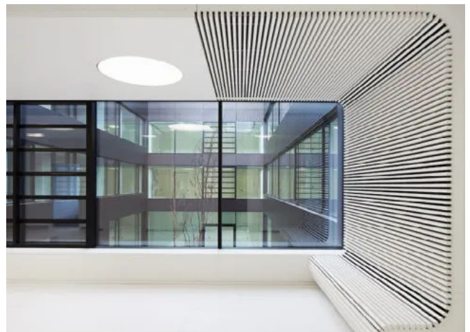
metogla Lamellendecken aus Esche im Verfügungsgebäude 1C der Technischen Universität, Cottbus | Architekt: bez+kock architekten, Stuttgart | Fotograf: bild_raum stephan baumann
