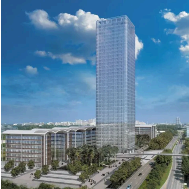
Uptown Büroturm München | Individuelle Steuerung mit LCN
