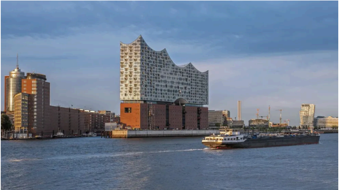
Elbphilharmonie Hamburg Herzog & de Meuron, Basel / Höhler+Partner - Architekten und Ingenieure, Hamburg
