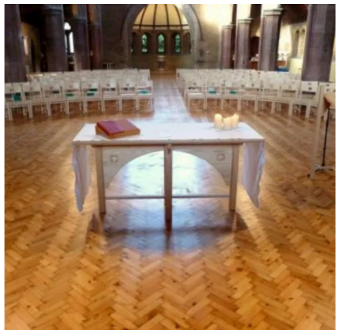
Fertiggestellter Bodenbelag auf dem Lithotherm-System – Altarbereich und Bestuhlung im sanierten Kirchenraum.
