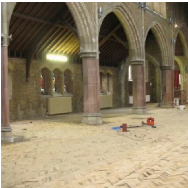
Abschluss der Bodenarbeiten. Der Parkettboden wird direkt auf dem Lithotherm System verlegt.
