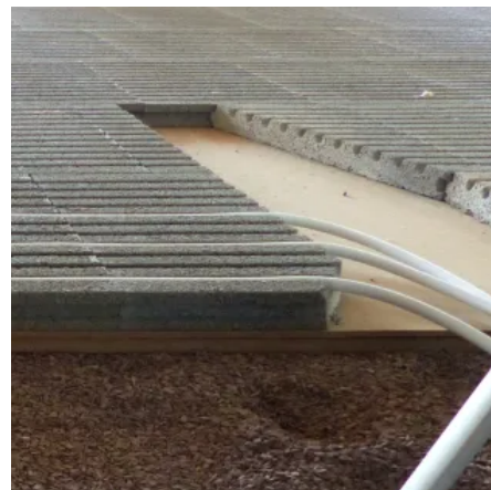
LITHOWOOD: Aufbau im Querschnitt
