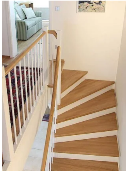
Aufgesattelte Wangentreppe in Eiche MB, Sondergeländer. 3647.1
