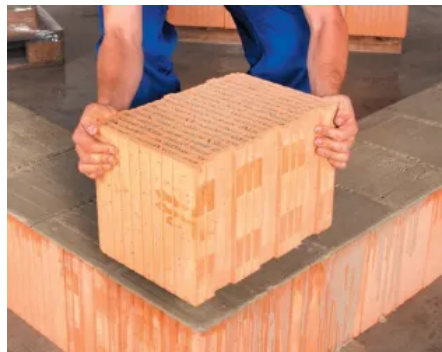
Mauerstein vollflächig auflegen
