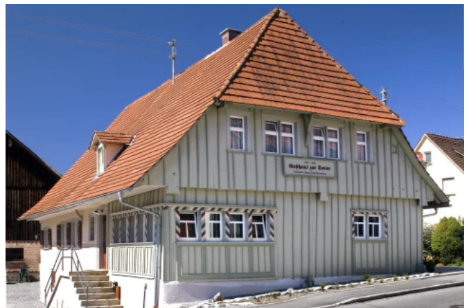
„Gasthaus zur Sonne“ - Planung: Eigentümer / Denkmalschutzbehörde | Foto: Caparol
