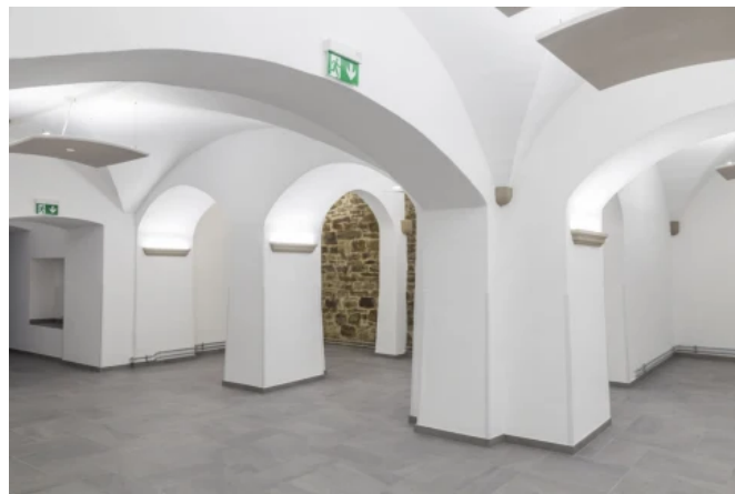
Gewölbekeller Schloss Hagerhof, Bad Honnef - Planung: Stefan Raffauf | Foto: Willi Fuchs Fotografie
