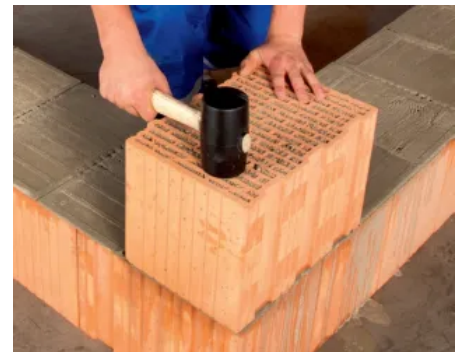
Mauerstein ausrichten
