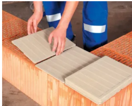
Auflegen der maxit mörtelpads
