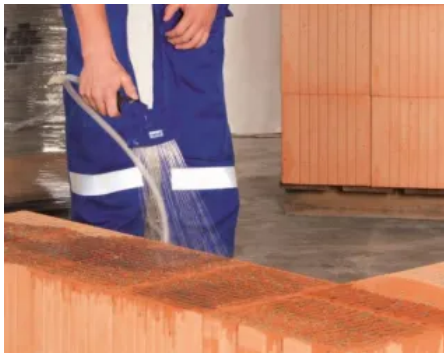
Mauersteine befeuchten
