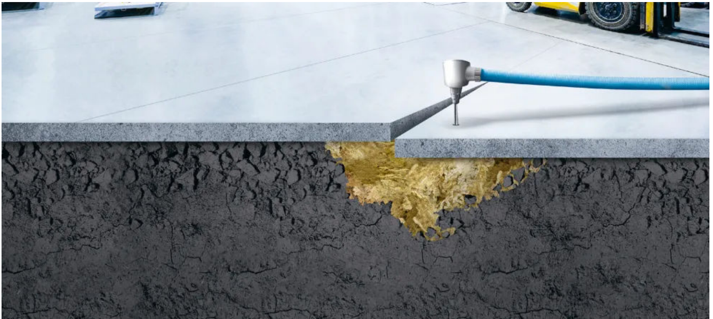
Betonbodenanhebung mit URETEK FloorLift®
