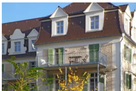
Bei der energetischen Sanierung der Wohnanlage „Neue Hofgärten“ in Ludwigshafen lag der Fokus darauf, die Anforderungen des Denkmalschutzes zu berücksichtigen.
