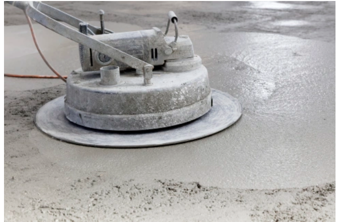
Einbau PCI Novoment® Z1
