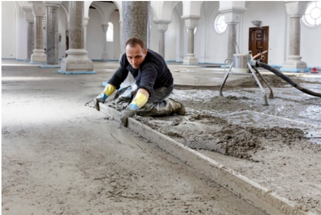
Einbau PCI Novoment® Z1
