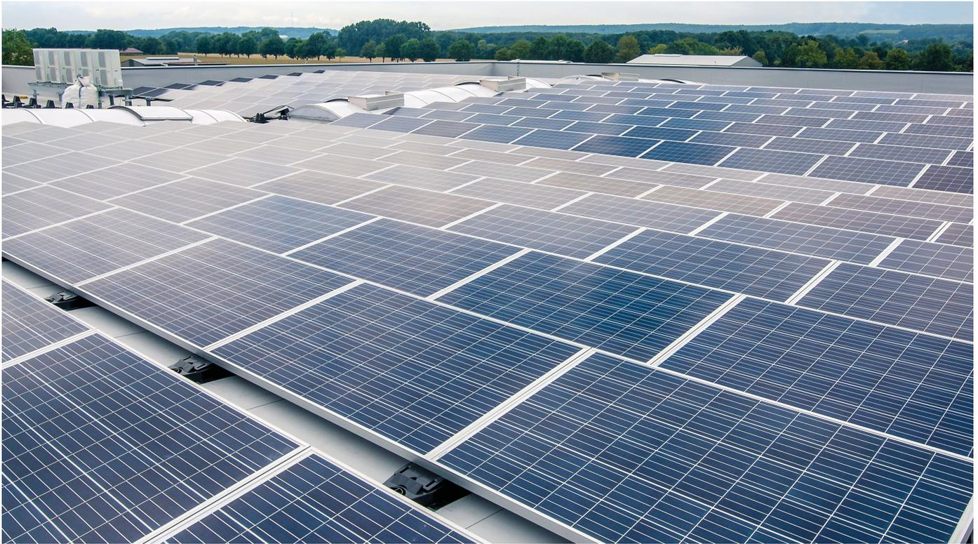
Systeme zur Montage von Photovoltaik-Anlagen auf Flachdächern: BauderSOLAR F ist für den Einsatz auf großen zusammenhängenden Dachflächen entwickelt worden.
