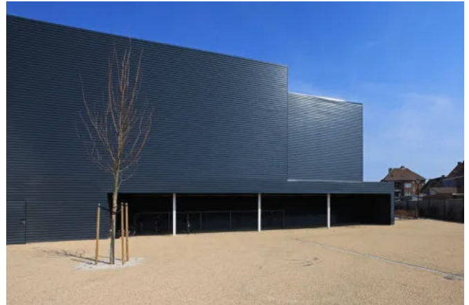
SAB Profilblech-Fassade, Beschichtung Colorcoat Dünnschicht Prisma Anthracite
