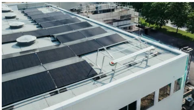
Das einklappbare Geländer erzeugt keinen permanenten Schatten auf den Solar-Modulen, was die Effizienz der Photovoltaikanlage erhöht.
