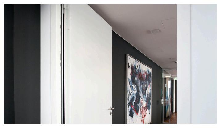
Rauchschutztüren von Teckentrup Door Solutions haben die Aufgabe, bei einem Brandfall den Durchtritt von Rauch so lange wie möglich zu verhindern. Sie werden u. a. für die Unterteilung von Fluren mit einer Länge von mindestens 30 Metern, sowie als Treppenhaus- und Flurabschluss verwendet.
