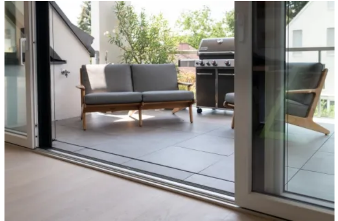
Verflieste Rinne, Privatobjekt
