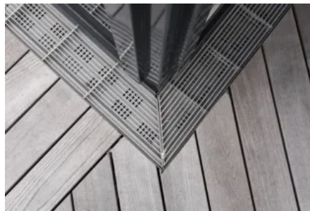
Drainrinne mit Linearrost, ESO Supernova Garching
