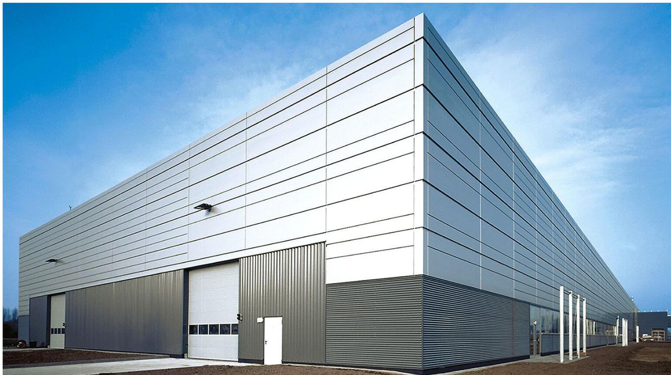
Sandwichelemente mit Mineralwolle Dämmkern (MiWo) eignen sich für Bauvorhaben mit hohen Brandschutzanforderungen. Die Sandwichelemente mit nicht-brennbarem Mineralwolle Dämmkern ermöglichen sichere Außenwandkonstruktionen, die sich mit PU-Sandwichelementen in identischer Geometrie und Fugenausbildung kombinieren lassen – für Fassaden mit durchgehend homogener Optik.
