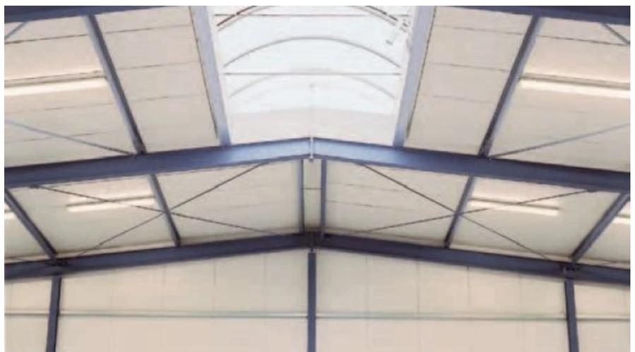
Lichtplatten aus schlagzähem PVC lassen sich passgenau integrieren.
