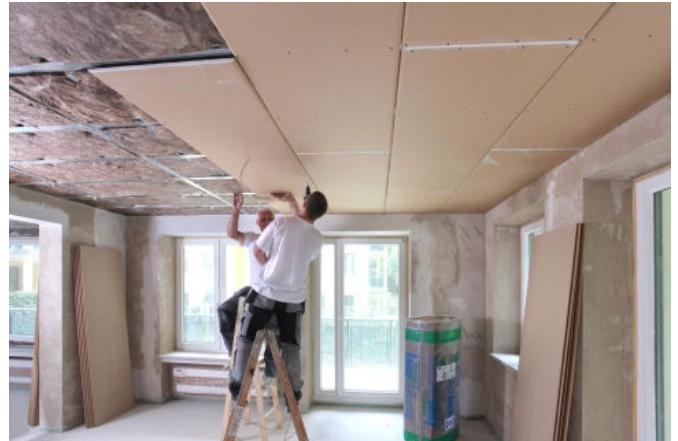
Bei Sanierungen erzielen Trockenbau-Unterdecken einen besseren Schallschutz an Holzbalkendecken.
