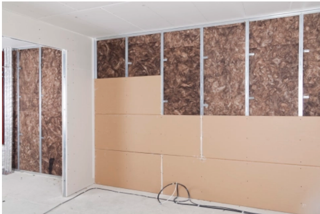
Trockenbau-Wände sind bei gleichen Schallschutzwerten wesentlich schlanker als ein verputztes Mauerwerk.
