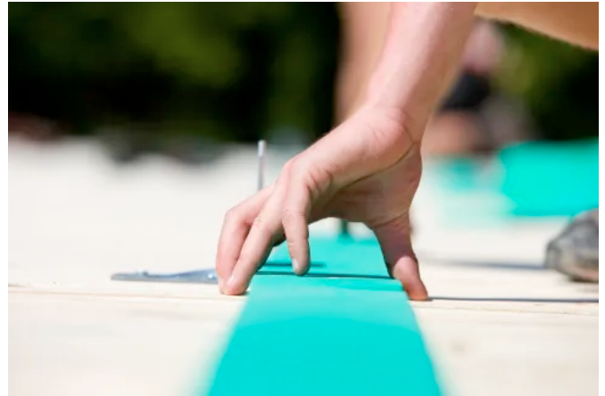
Anwendung im Holzständerbau
