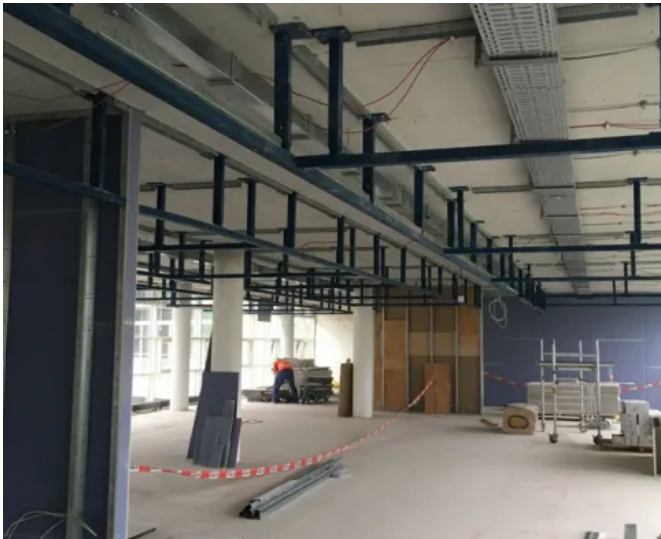
Abschottung FA-DI - Deckenschürzensysteme für Installationen
