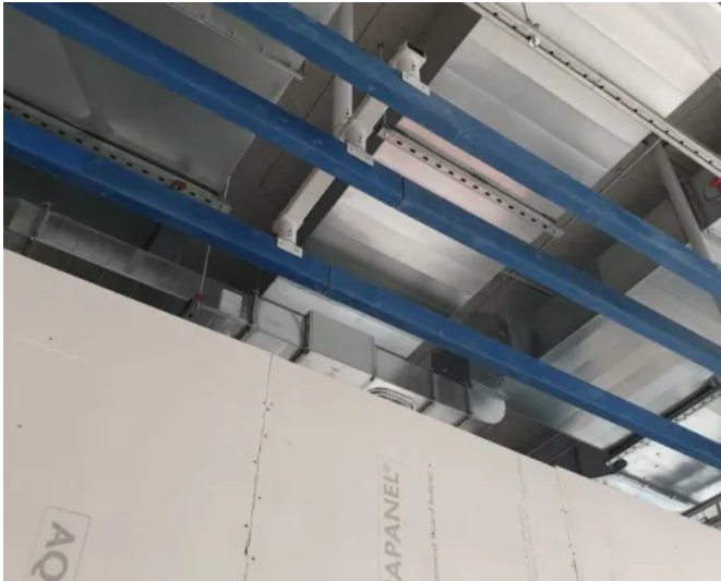
Unterkonstruktion für Abschottungen FA - Traversal
