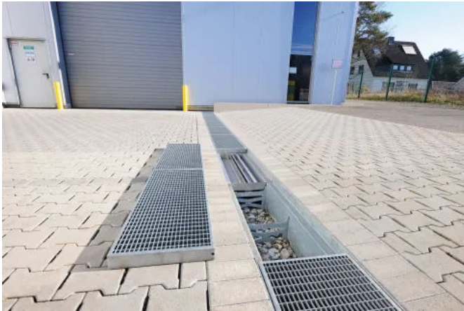
Es wurden versickerungsfähige Rigolenrinnen „RigoMax“ für eine 120 Quadratmeter große Pflasterfläche verbaut.
