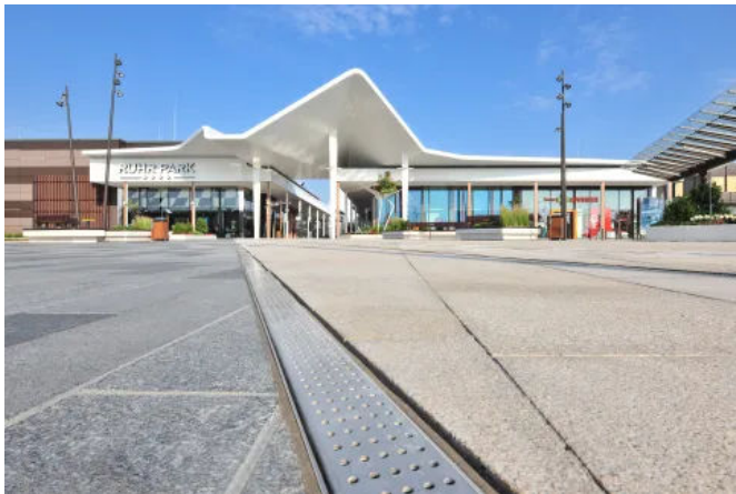
Maßgefertigte Schwerlastrinnen des Typs „Stabile Magna“ im Fußgängerbereich des Einkaufszentrums.
