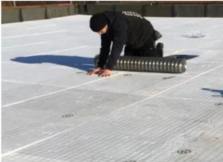
smartex® is Edelstahlgitter dienen als Kontaktlage unterhalb der Abdichtungsbahn und sind über Sensorkabel mit dem System verbunden.
