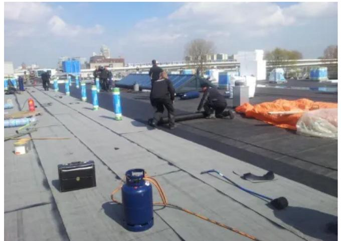
Die Komponenten der smartex®-Systeme werden in den Abdichtungsaufbau integriert.
