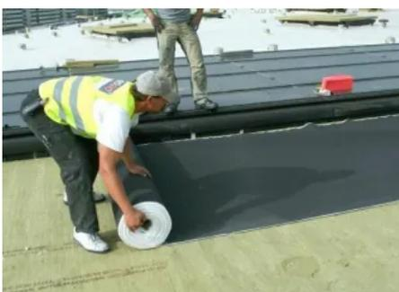
smartex® vm nutzt eine elektrisch leitfähige Kontaktlage unterhalb der Abdichtung für die elektronische Prüfung der Abdichtung.
