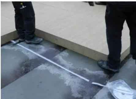
smartex® dm misst eintretende Feuchtigkeit über Sensorbänder, die auf der Dampfsperrebene angeordnet sind.
