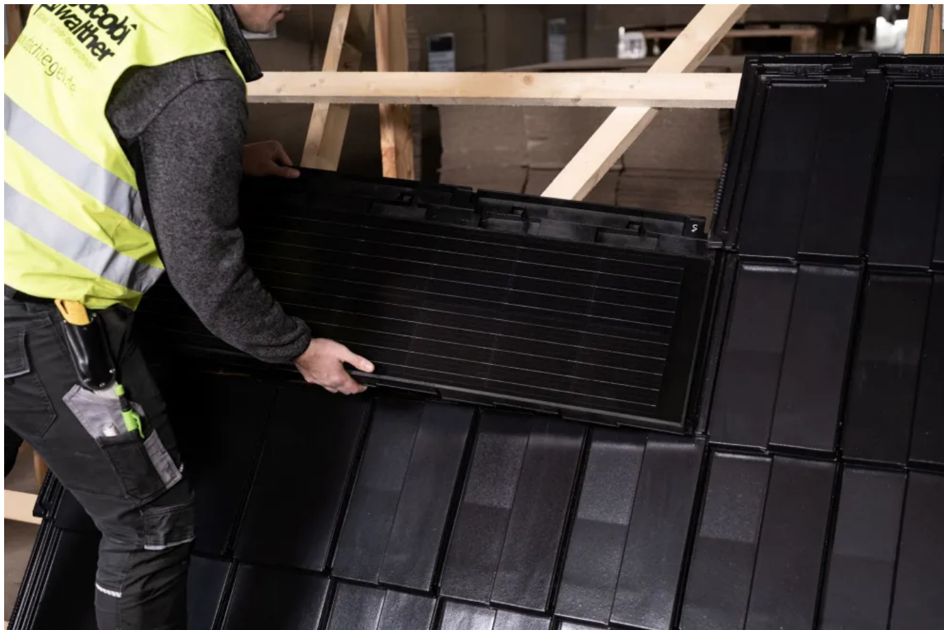
Verlegung der J160-PV Indach-Module
