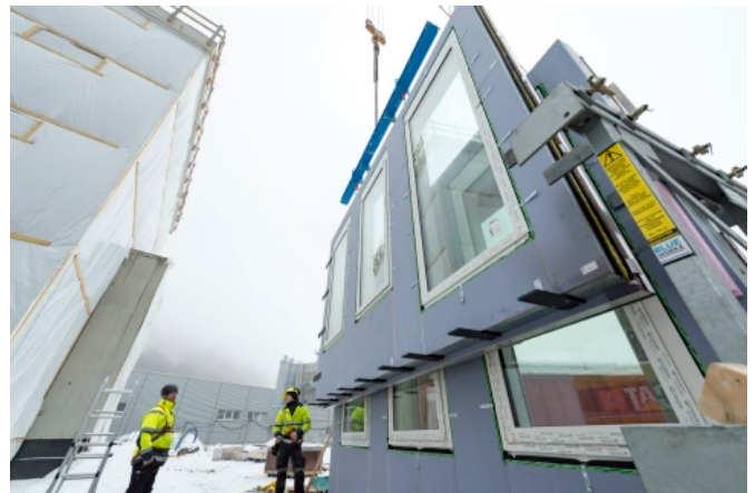
Knauf Stahl-Leichtbau-Profile können als Bauelemente oder ganze Raumzellen verbunden werden. So entstehen Baumodule für Schulen, das Gesundheitswesen oder den Hausbau.
