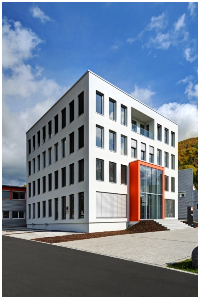
Knauf Stahl-Leichtbau-Fassade, Kubus AMF, Grafenau
