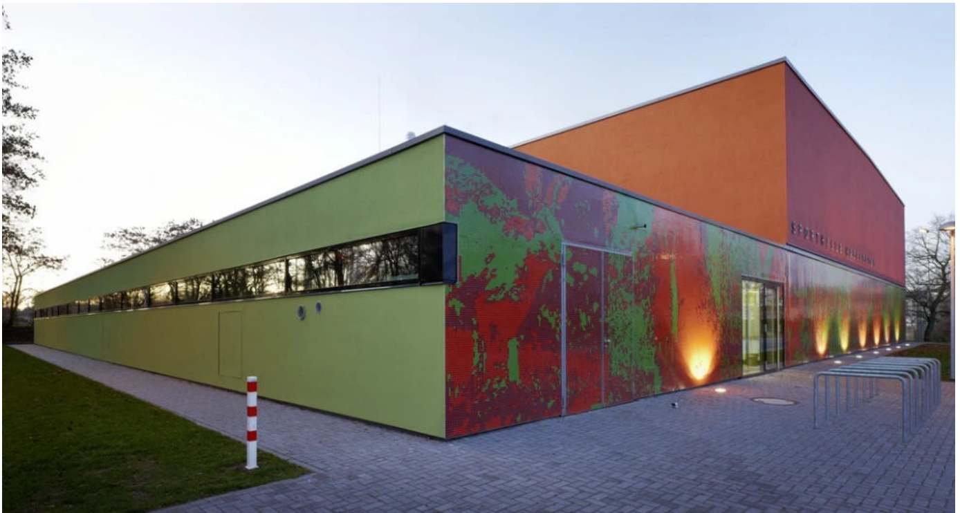
Sporthalle, Rüsselsheim, DE, Foto: lumen-Joppich und Dörr GbR, Frankfurt, DE
