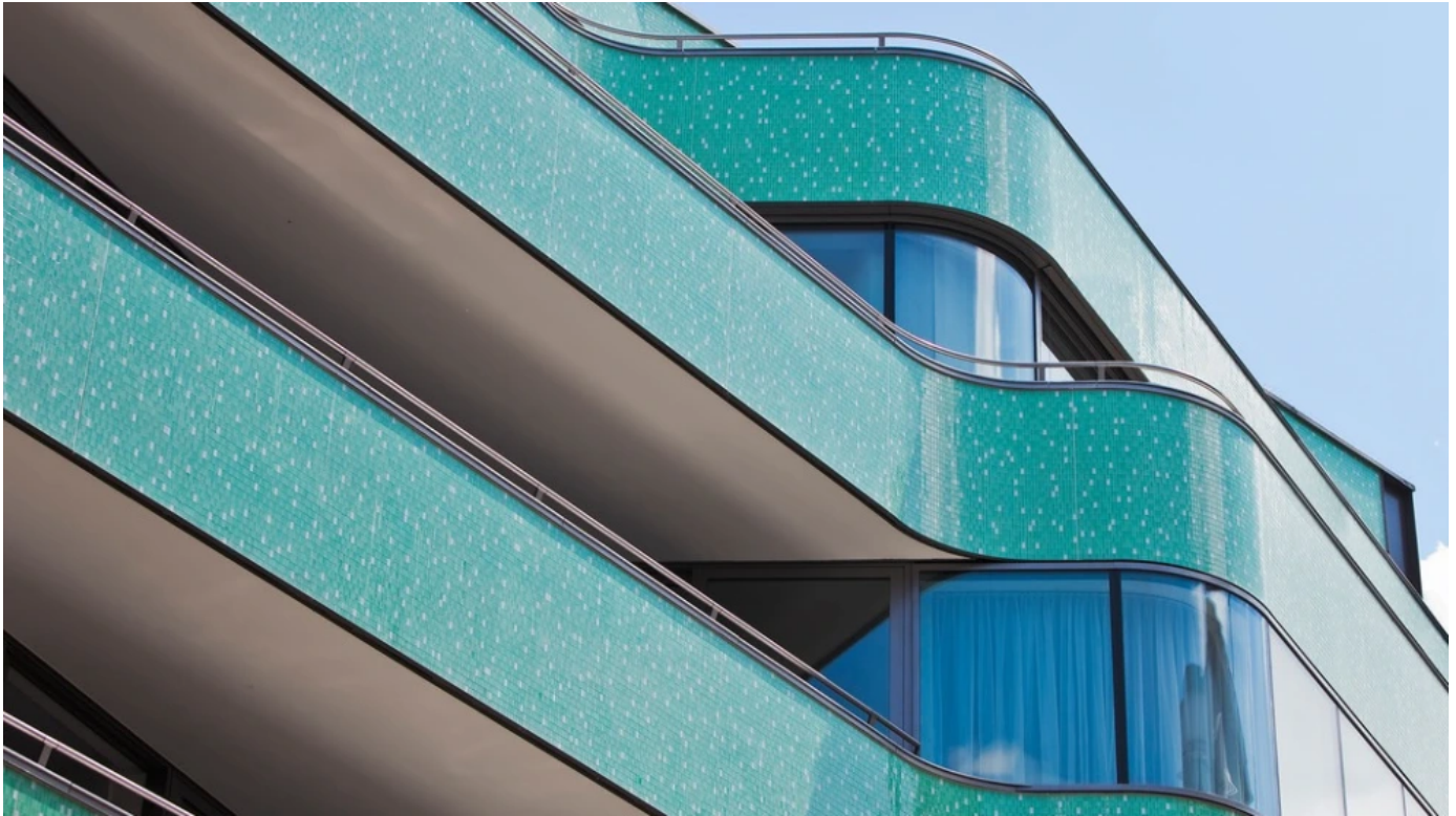
Wohn- und Geschäftsgebäude, Frankfurt a. M., DE Foto: Ben Knabe, Köln, DE
