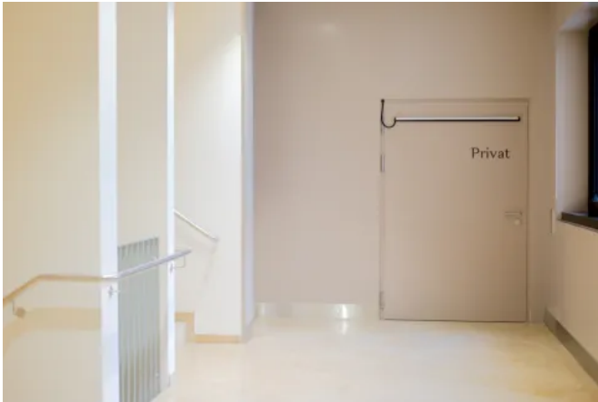
Feuerhemmende und rauchdichte Stahltür T 30-2-RS „System Schröders TSN-2“ Minto Mönchengladbach
