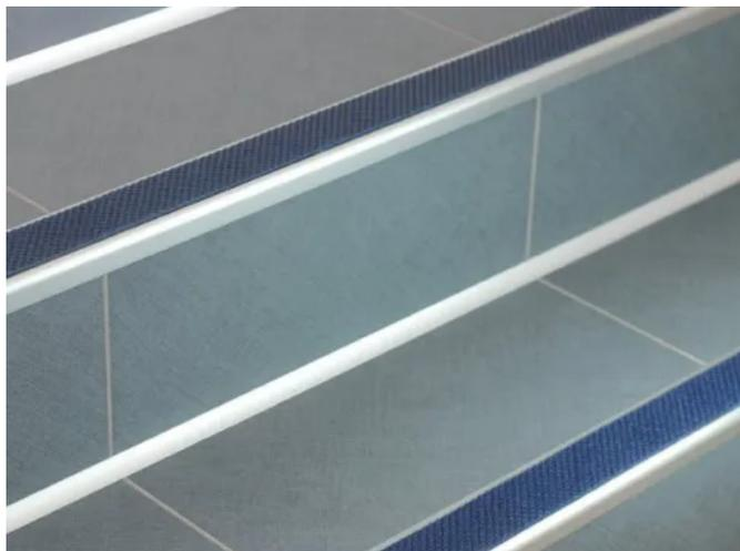
Treppenstufenprofile TREDSAFE mit rutschhemmender Einlage zur nachträglichen Verlegung auf allen Treppenbelägen – wahlweise mit Stoßkanten für saubere Belagsübergänge/dünne Belagsarten, mit integriertem Belagseinzug sowie unterschiedlichen Stufenkantenformen.
