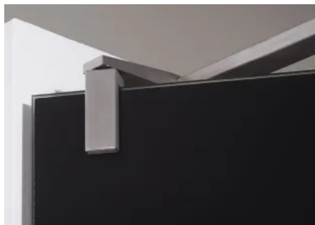
Oberer Halter der Scharnierkonstruktion. Die Tür wird im Kopfprofil geführt.
