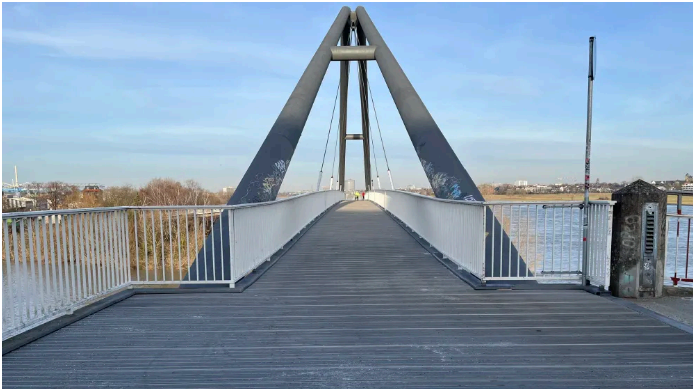
Sanierung der Brücke am Medienhafen in Düsseldorf mit TRIMAX® mit geriffelter Oberfläche in grau
